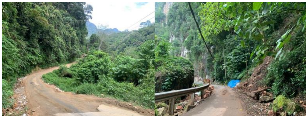
Gambar 4. Kondisi Infrastruktur Wisata Geopark Silokek
